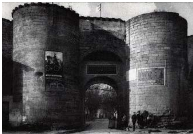
Localisation: Porte de la Condamine
